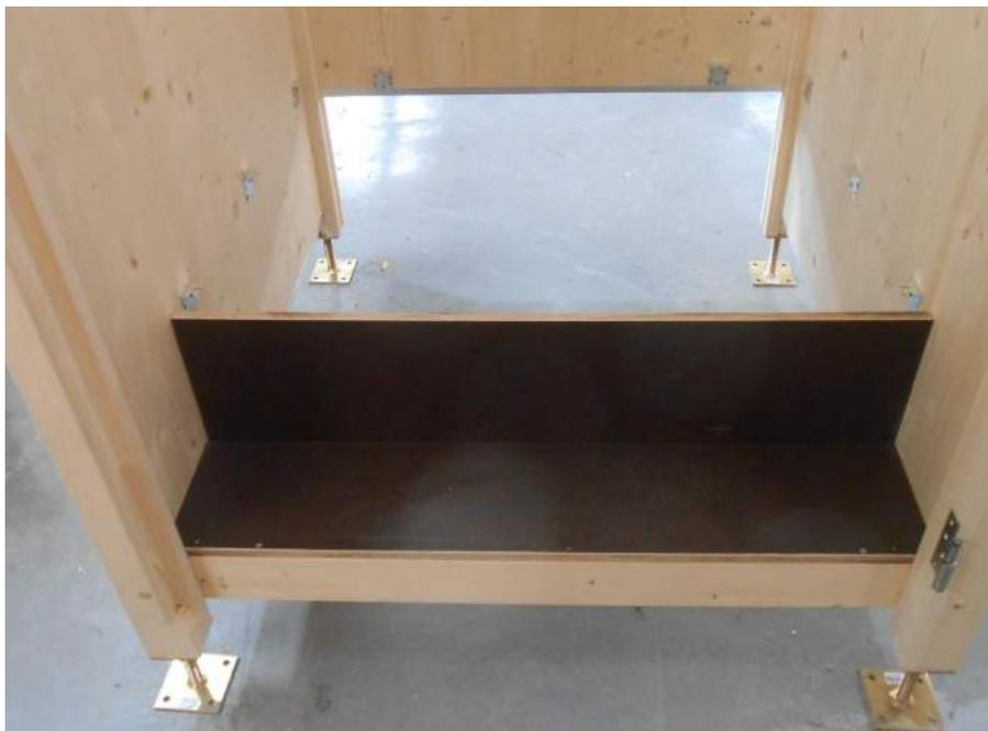
**7c)** Falls nicht schon geschehen, schrauben Sie die beiden unteren Winkel an der Rückwand an. Legen Sie dann die Bodenplatte mit dem Ausschnitt auf die Winkel, die raue Seite schaut wieder nach oben, der schmale Streifen der Platte schaut zur Rückwand. Schrauben Sie nun die Platte von unten pro Winkel mit zwei Euroschrauben fest. Die Platte mit der Bodenblende wird dann noch mit 5x55er Holzschrauben verbunden.
