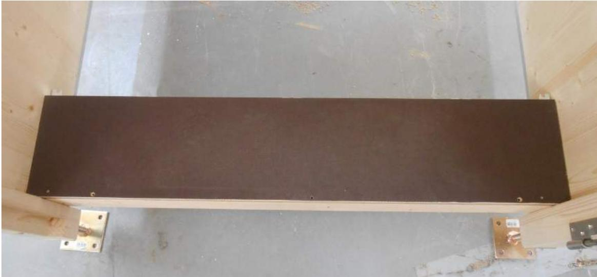
**b)** Die Bodenblende (Maße 1041 x 250 x 18 mm) wird mit erst mit den Winkeln angeschraubt und dann mit 5x55er Holzschrauben von hinten mit der Trittstufe verbunden. Achten Sie dabei darauf, die Trittstufe beim Verschrauben nicht zu belasten, da diese sich sonst durchbiegen könnte und das zu einer fehlerhaften Positionierung führen könnte.
