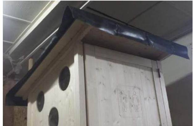
**b)** Richten Sie nun die Dachabschlussleisten aus Alu her. Nehmen Sie die 3x16er selbstbohrenden Schrauben und setzen Sie bei allen Dachanschlüssen ca. alle 150 mm eine Schraube an. Schrauben Sie die Schrauben nur ein kleines Stück rein, so dass diese nicht rausfallen. Die selbstbohrenden Schrauben haben einen kleinen Bohrkopf und müssen daher nicht extra vorgebohrt werden. Starten Sie beim Schrauben mit der schnellen Stufe des Akkusraubers und arbeiten Sie mit leichtem Druck.
