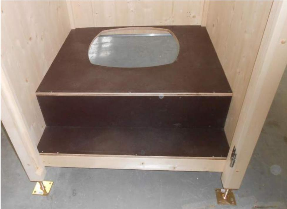
**d)** Die Ablage links können Sie einfach mittels der Winkel anschrauben. Der Spänebunker erfordert etwas Koordination, weil nicht alle Stellen mit dem Akkuschrauber erreicht werden können. Schrauben Sie also die Winkel erst so wie im Bild zu sehen an und vollenden Sie dann das Werk.
