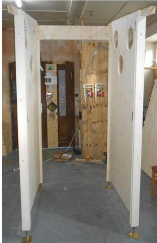
b) Die untere Verbindungsstrebe hat ein Maß von 1041 x 100 x 40 mm und wird mit 5 x 60 mm Holzschrauben bündig mit der Unterkante der Alu Schienen der Seiten an die Kanthölzer geschraubt.
