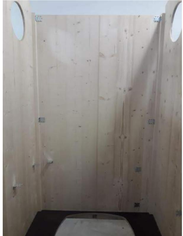
**b)** Die Toilette steht nun schon einigermaßen stabil und Sie können eine erste Ausrichtung mit der Wasserwaage vornehmen. Lassen Sie sich beim Anheben der Toilette wieder helfen, verwenden Sie hierfür z.B. ein Kantholz zum Hebeln.
